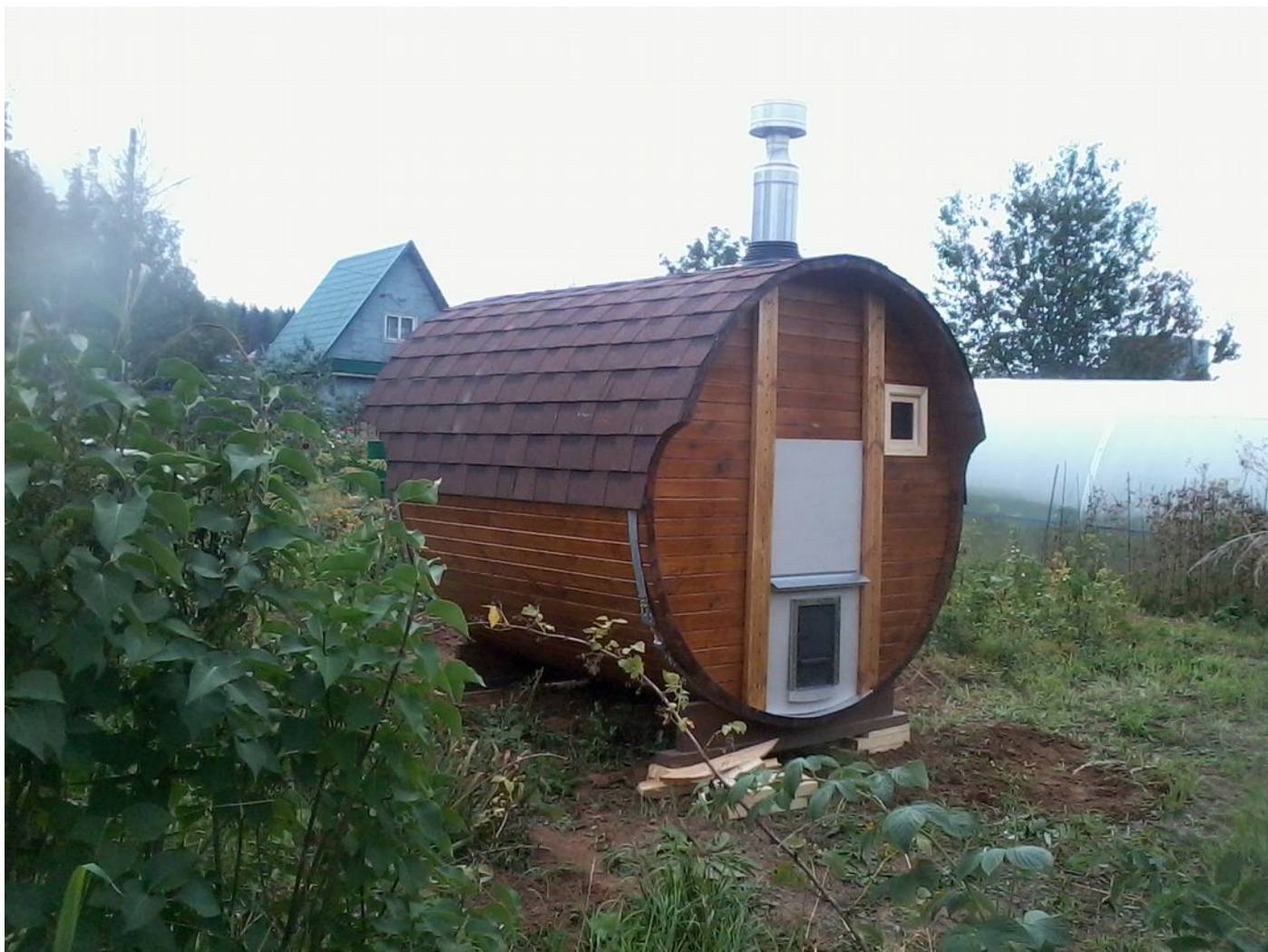
Фото №2. Общий вид. Печка обслуживается с улицы.
